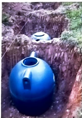
Figura 7 – Sistemas locais individuais de tratamento e disposição final de esgotos em aplicação-piloto na cidade de Santo André
