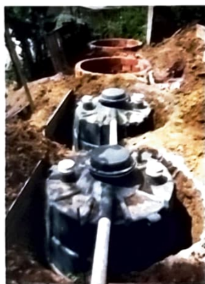
Figura 7 – Sistemas locais individuais de tratamento e disposição final de esgotos em aplicação-piloto na cidade de Santo André
