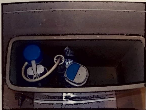
BACIA SANITÁRIA COM CAIXA ACOPLADA COM VAZÃO DE ÁGUA DE 3L PARA DESCARGA DE LÍQUIDO OU DE 6L PARA ELIMINAÇÃO DE MATERIAL SÓLIDO
