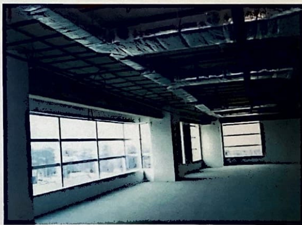
APROVEITAMENTO DE LUZ NATURAL, ATRAVÉS DE VIDROS QUE REDUZEM O GANHO DE CALOR SOLAR E SISTEMA AR CONDICIONADO PROTEGIDO PARA QUE OS DUTOS NÃO FIQUEM SUJOS POR DENTRO COM A POEIRA DA OBRA.
