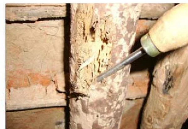
Foto 6 – Detalhe da peça estrutural de uma parede de pau a pique com ataque de cupim de madeira seca
