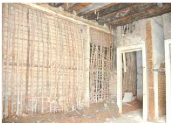
Foto 3 – Arcabouço de um painel de pau-a-pique desnudado pela enchente
