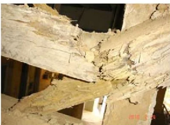
Foto 5 – Aspecto de uma peça estrutural severamente atacada e rompida devido ao ataque intenso de cupins de madeira seca e fungos apodrecedores
