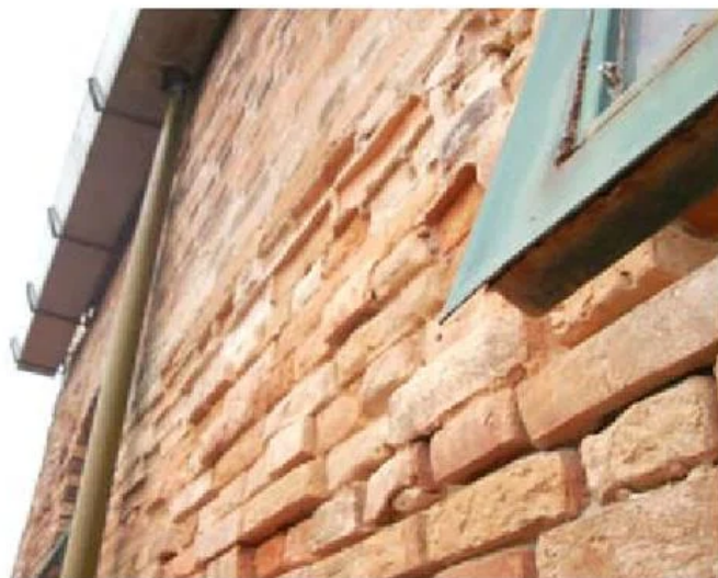
Foto 3: Detalhe de parte da fachada onde se observa a degradação dos tijolos e a corrosão dos caixilhos de ferro.
