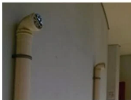
Figura 4 – Detalhe dos pontos de captação de ar atmosféricos
