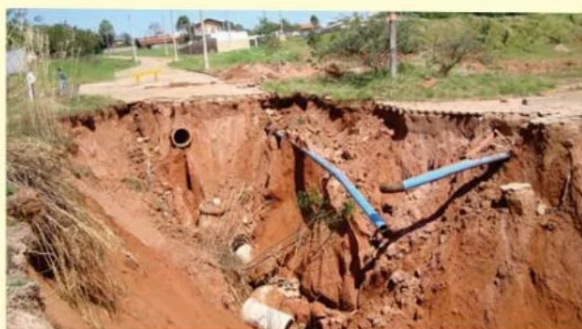
Figura 3 – À esquerda, a mesma erosão mencionada na Figura 2 em Set/2015, atingindo o sistema viário e a rede de abastecimento de água. À direita, a mesma erosão em Out/2015 destruindo a rede de águas pluviais.
