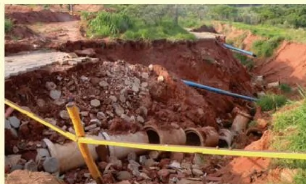
Figura 3 – À esquerda, a mesma erosão mencionada na Figura 2 em Set/2015, atingindo o sistema viário e a rede de abastecimento de água. À direita, a mesma erosão em Out/2015 destruindo a rede de águas pluviais.
