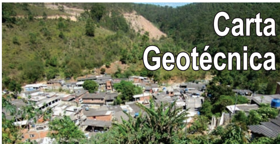
Bairro Chácara Solar: situações de risco de atingimento de material de ocupação à montante (set/2019). Observar bota-fora na encosta, com desmatamento expressivo.
