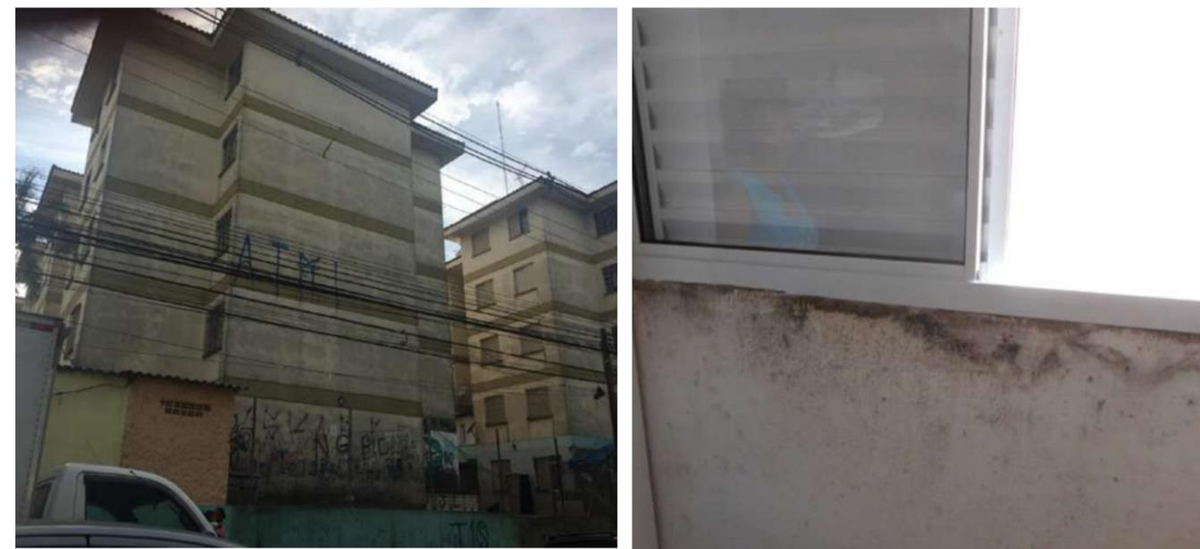
Figura 4: Edifícios habitacionais com problemas de umidade que afetam a habitabilidade e, consequentemente, a durabilidade (face externa e interna da parede de fachada) Fonte: autora
