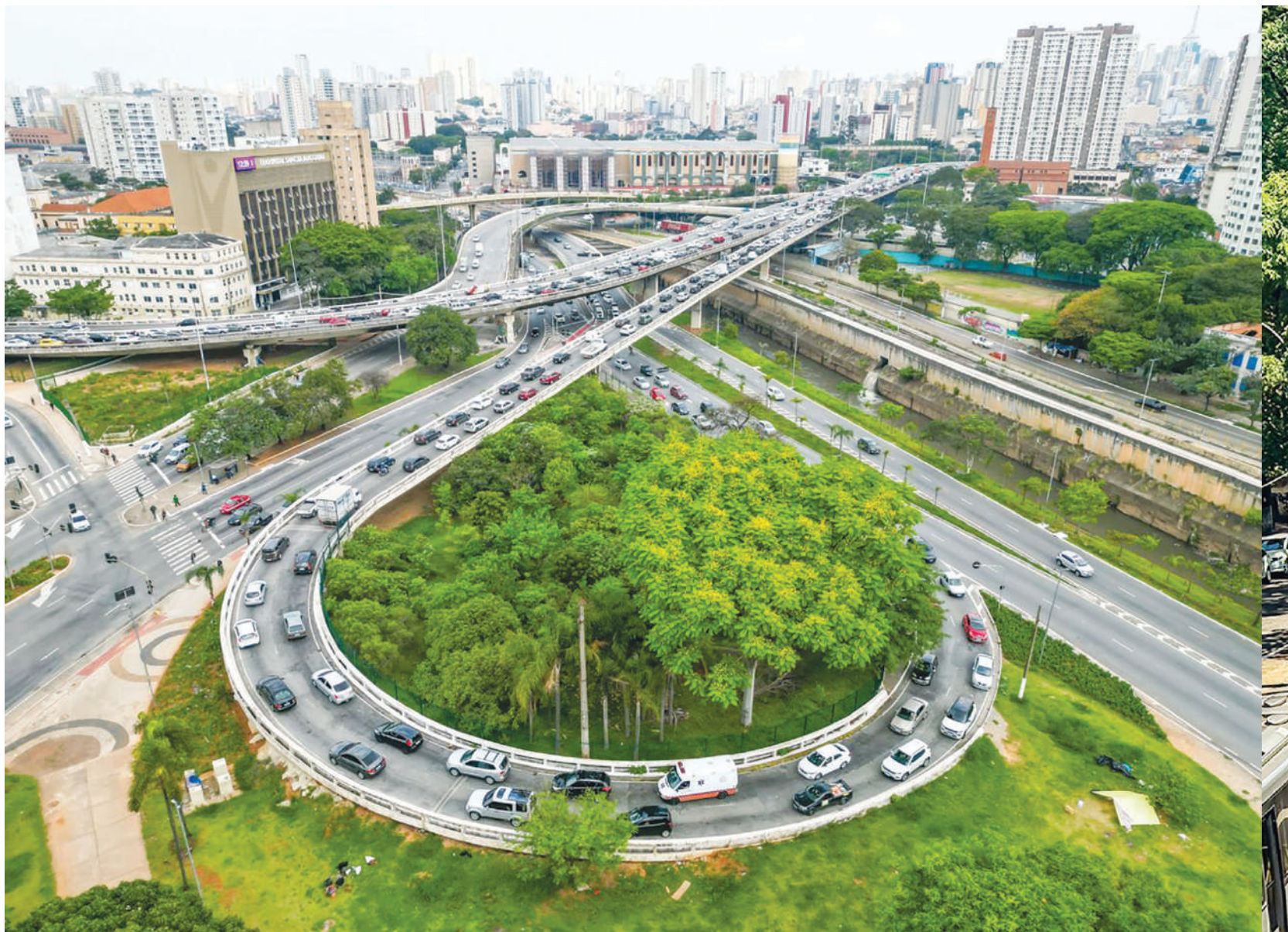
Jardim de Chuva na região central: solução natural para melhorar a drenagem urbana
